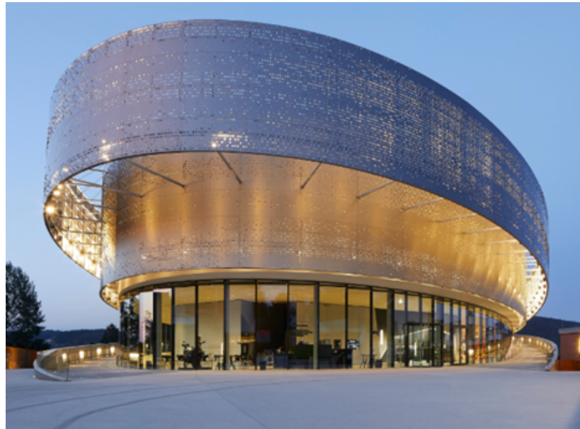
©Unger Stahlbau Ges.m.b.H.+ Werkraum Ingenieure ZT GmbH
