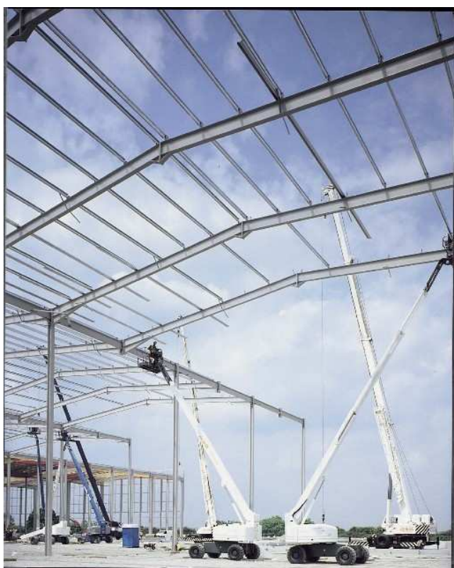
Rysunek 3.14 Proces montażu nowoczesnych ram portalowych
