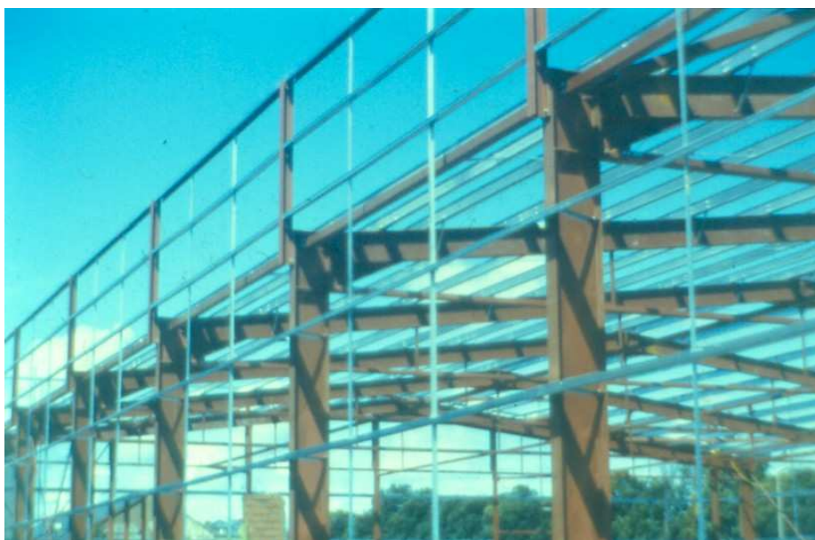
Rysunek 3.2 Typowe ramy portalowe i elementy drugorzędne
