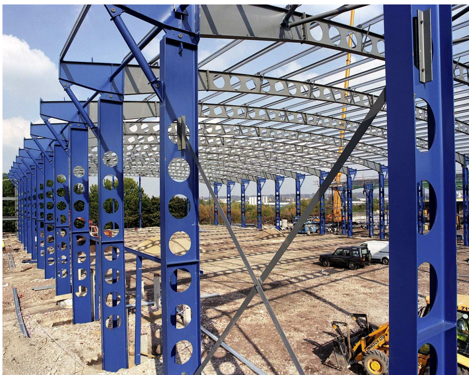
Rysunek 3.4 Innowacyjne połączenia sztywne w budynku przemysłowym
