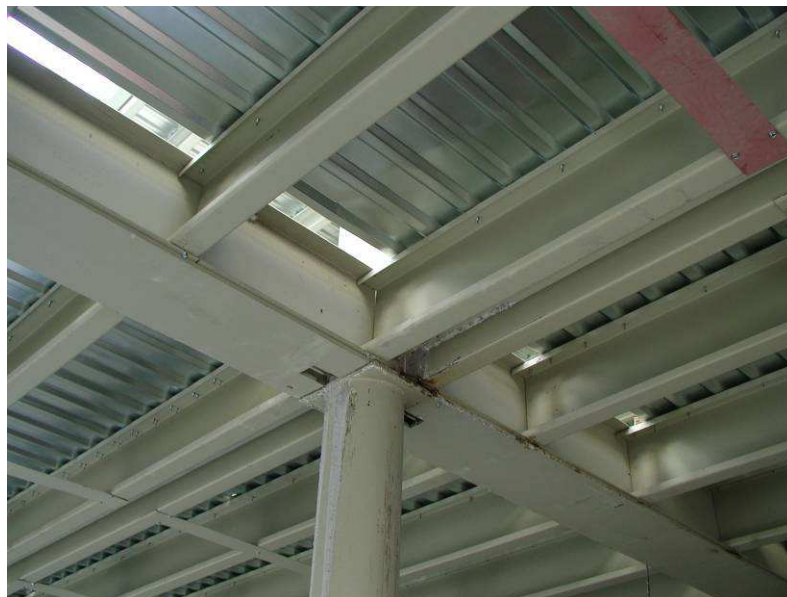
Rys. 2.4 Zastosowanie gorąco walcowanych belek jako wsparcie stropu o lekkiej konstrukcji stalowej
