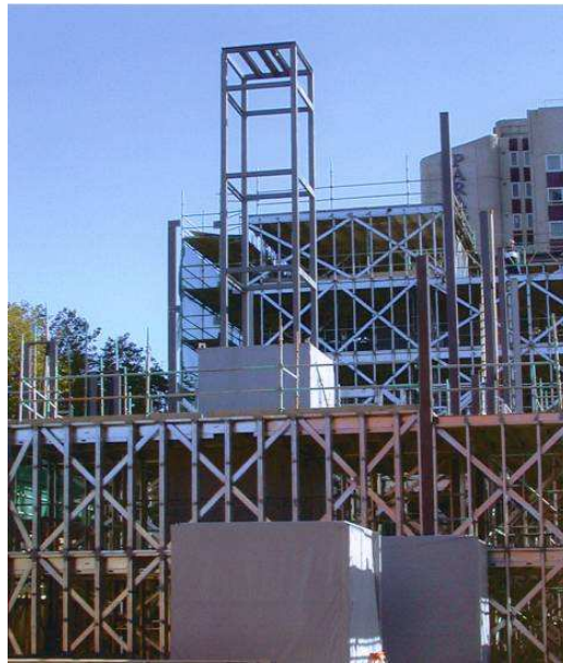
Rys. 2.3 Prefabrykowana wieża klatki schodowej z kształowników gorąco walcowanych i moduły umieszczone w lekkiej konstrukcji stalowej
