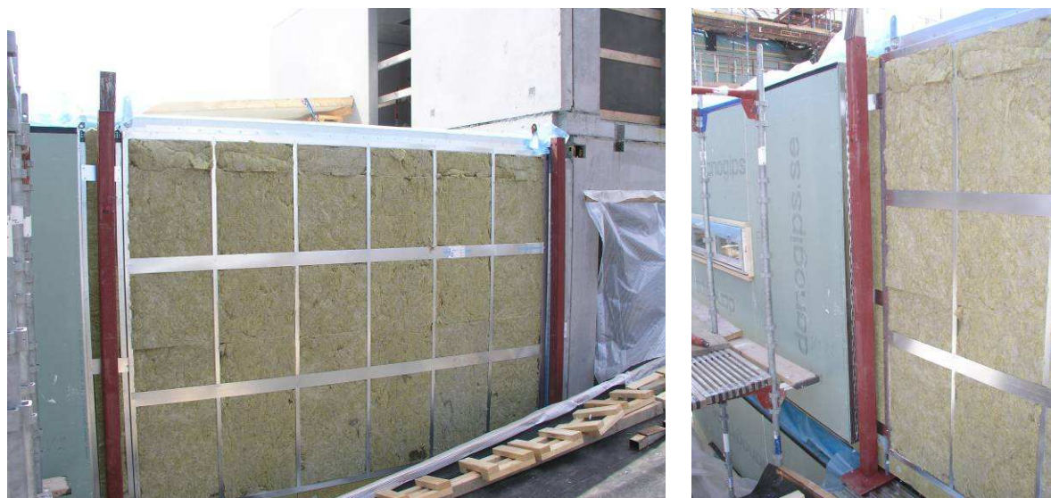
Rys. 2.2 Prefabrykowane moduły w połączeniu ze szkieletem nośnym w udanym systemie konstrukcyjnym budynków mieszkalnych w Szwecji.
