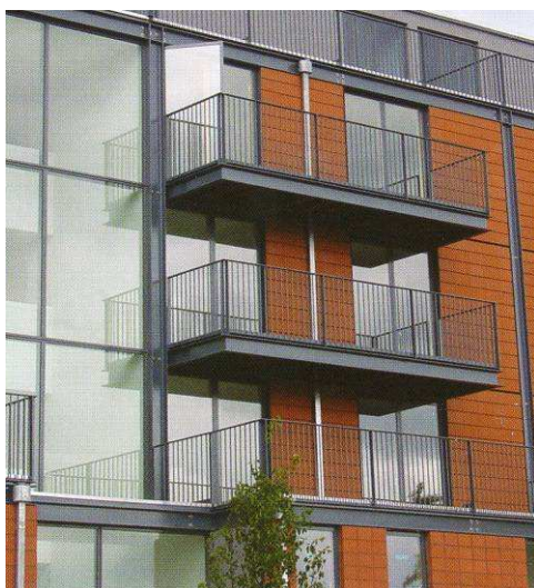
Rys. 2.1 Balkony z kształtowników gorąco walcowanych włączone do lekkiej konstrukcji stalowej
