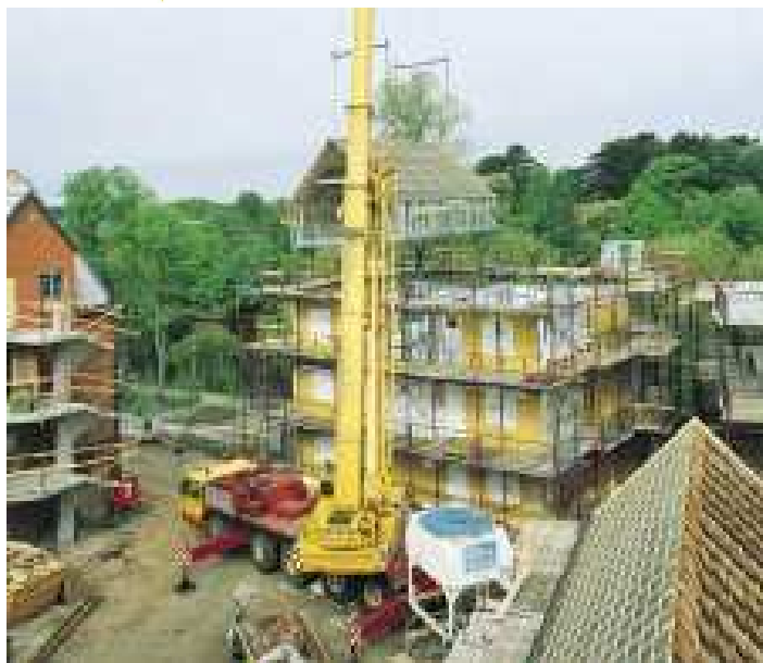
Rys. 2.1 Scalona część dachu podczas podnoszenia (Źródło: Lindab Profil AB).
