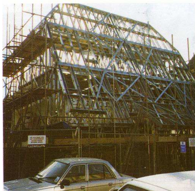
Rys. 1.3 Dach typu „Rama A” – konstrukcja dachu mieści trzy kondygnacje mieszkalne.
