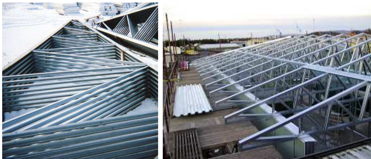
Rys. 1.1 Typowa stalowa lekka konstrukcja kratownicowa- jest to potrzebne dla rozwoju lekkich kratownic stalowych znaczących rozpiętości.(Przykład: zdjęcie po prawej-Lindab profil AB).
