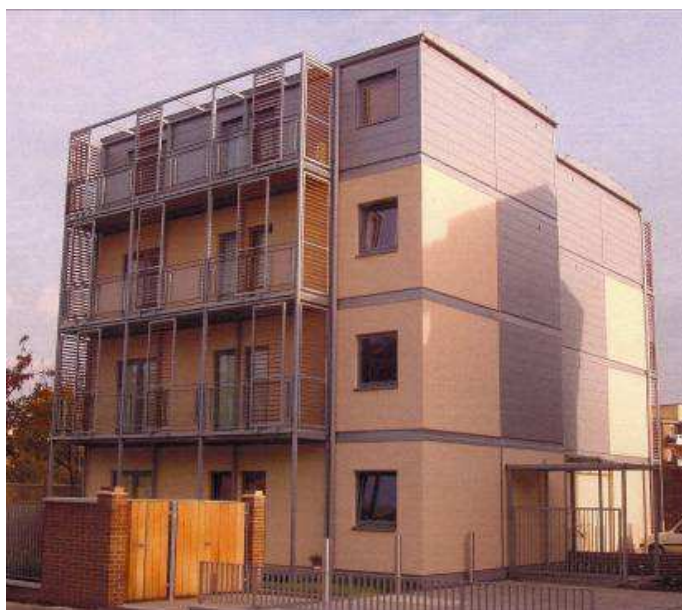
Rys. 4.4 Moduły zostały wyprodukowane w Polsce i zmontowane w Londynie
