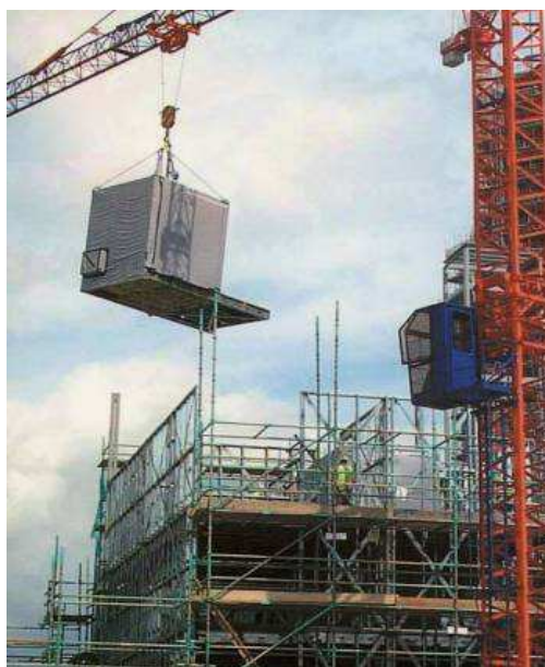
Rys. 4.3 Kontener zawierający łazienkę podnoszony na budowie Beaufort House - Londyn
