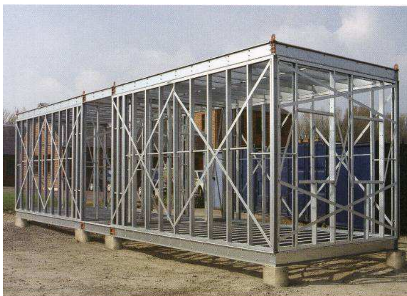
Rys. 4.1 Jednostka modułowa ograniczona tylko do konstrukcji
