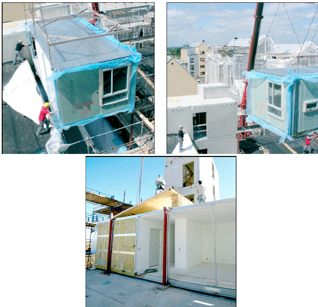
Rys. 4.2 Trzy fotografie pokazują system modularny „Open House”. Moduły są wytwarzane w wytwórni i są montowane wraz z słupkami na placu budowy
