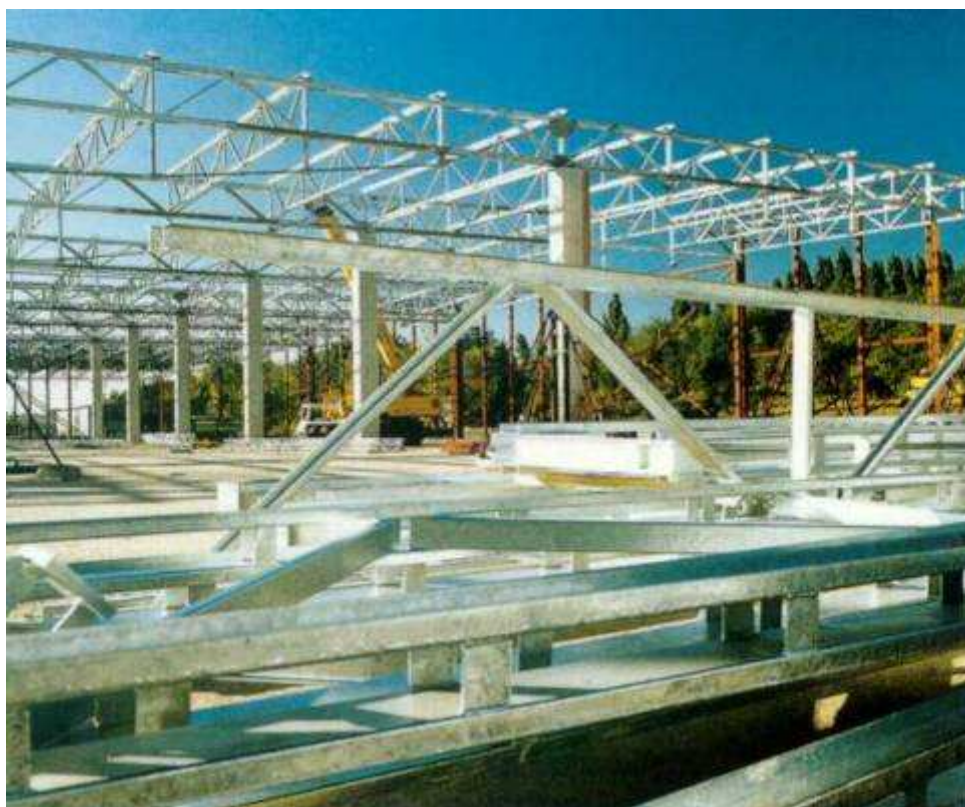
Rys. 5.1 Kratownice cynkowane ogniowo. Źródło: ATEG (Spanish Galvanizing Technical Association)
