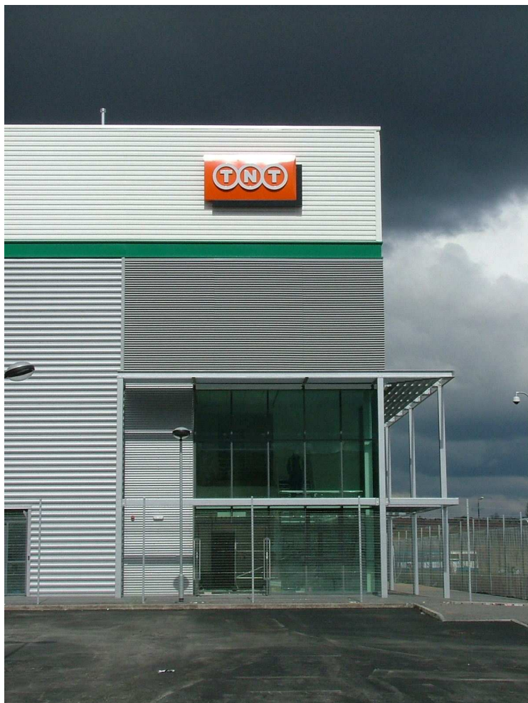
Rys. 2.2 Budynek złożony z magazynu i biura ma imponujący wygląd, gdy obudowa jest wykonana poprzez zastosowanie różnych profili, wykończenia i różnych kolorów (Fotografia udostępniona grzecznościowo przez Michael Sparks Associates)
