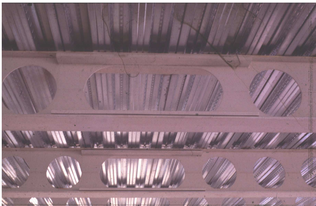
Rys. 2.3 Wydłużone otwory w belkach ażurowych
