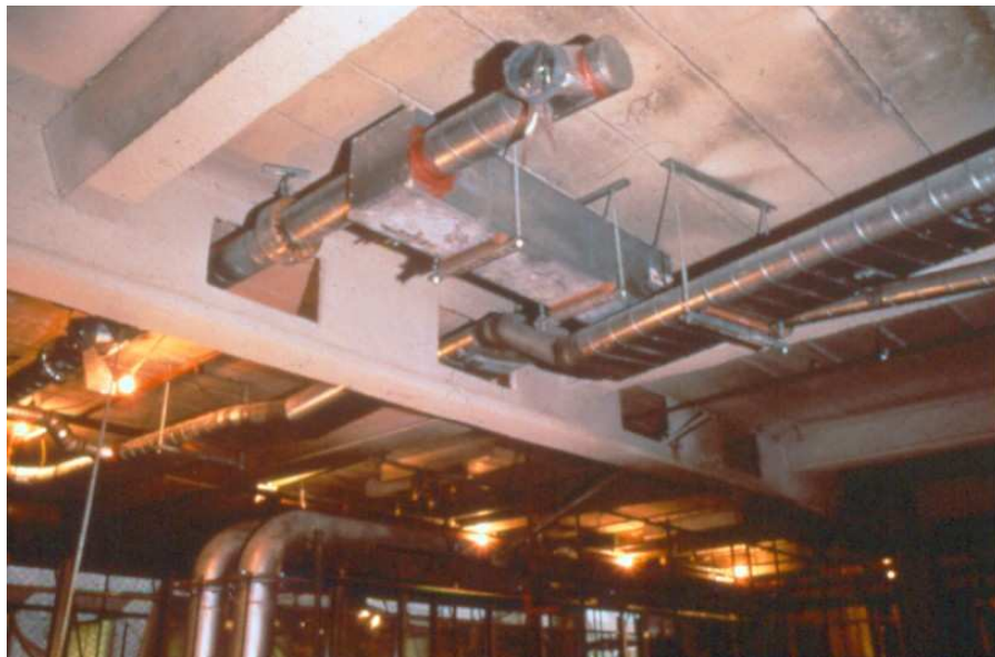
Rys. 2.2 Seria prostokątnych otworów w belce głównej
