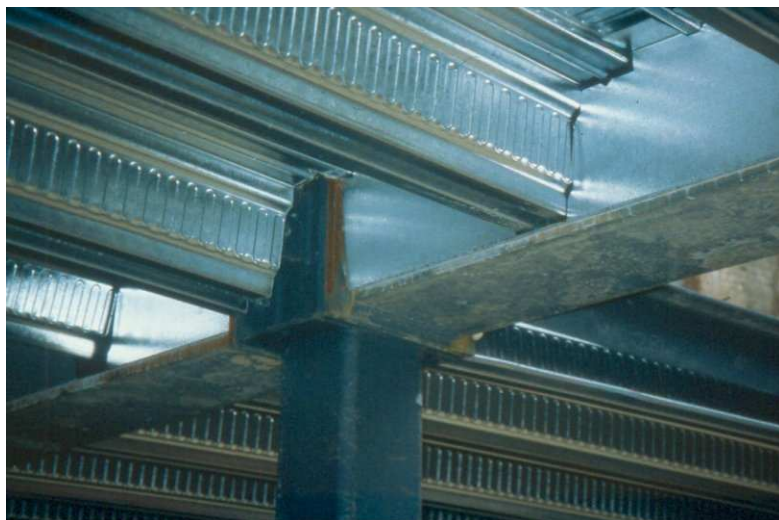
Rys. 1.4 Wysoki profil stalowy i belka 'slim floor'
