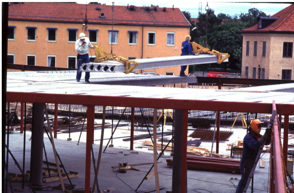
Rys. 1.3 Belki zintegrowane budowanie z zastosowaniem betonowych płyt prefabrykowanych
