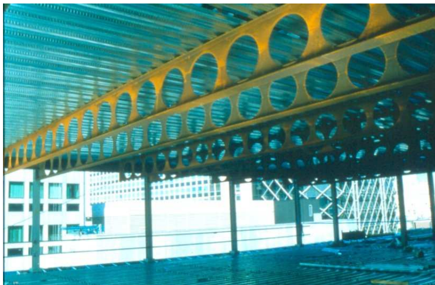
Rys. 1.4 Belki ażurowe o dużej rozpiętości
