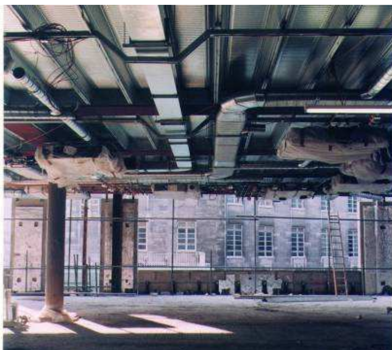
Rys. 6.3 Instalacje poniżej konstrukcji stropu typu "Slimdek" [17]
