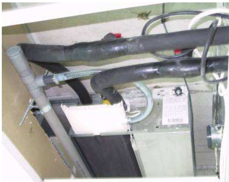
Rys. 3.1 Klimakonwektor z jego własnymi przewodami instalacyjnymi
