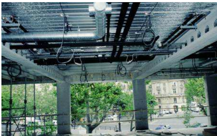
Rys. 6.10 Belki ażurowe z instalacjami przechodzącymi przez otwory w środkach [15]
