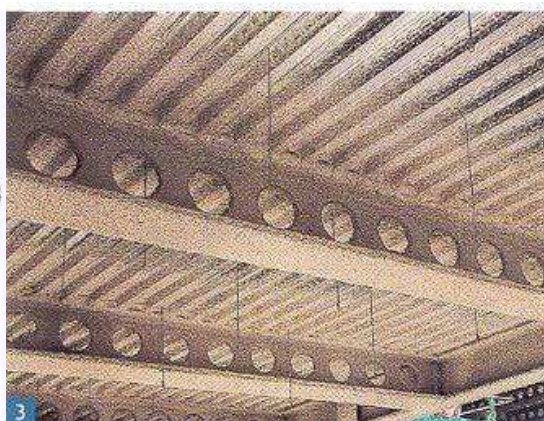
Rys. 6.9 Typowe belki ażurowe z otworami kołowymi [7]
