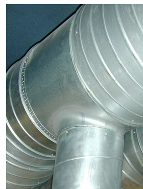
Rozgałęzienie teowe (typu T) (1,5 średnicy)
