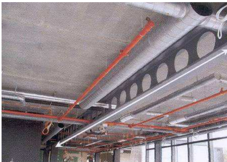
Rys. 6.11 Belki ażurowe z instalacjami przechodzącymi przez otwory w środnikach [15]
