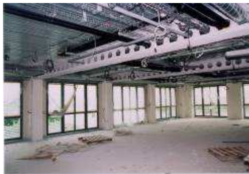
Rys. 6.11 Belki ażurowe z instalacjami przechodzącymi przez otwory w środnikach [15]
