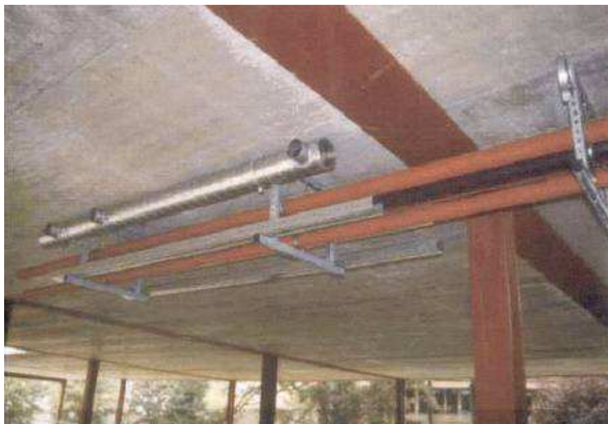
Rys. 6.2 Żelbetowa prefabrykowana płyta stropowa - na rys. zintegrowana z belkami stalowymi: Poniżej płyty potrzebna jest strefa do montażu instalacji [15]
