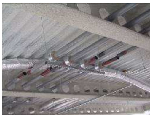
Rys. 6.12 Przykłady integracji instalacji z belkami ażurowymi
