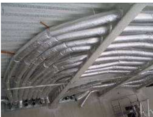
Rys. 6.12 Przykłady integracji instalacji z belkami ażurowymi
