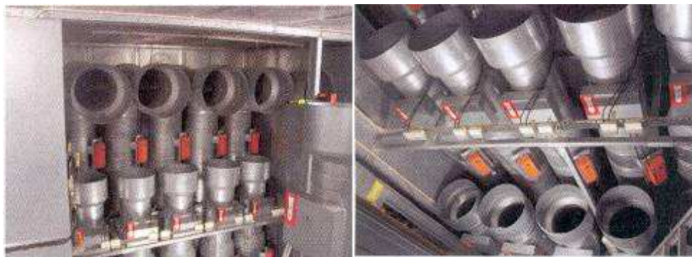
Rys. 2.1 Drogi instalacyjne z trzonu instalacyjnego [3]
