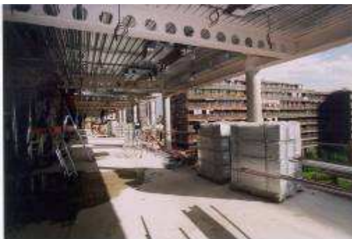
Rys. 6.11 Belki ażurowe z instalacjami przechodzącymi przez otwory w środnikach [15]
