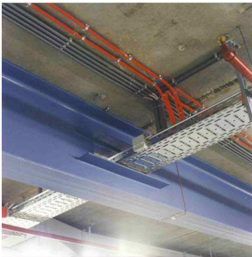
Rys. 6.7 Mały otwór w belce do przepuszczenia instalacji elektrycznej [15]
