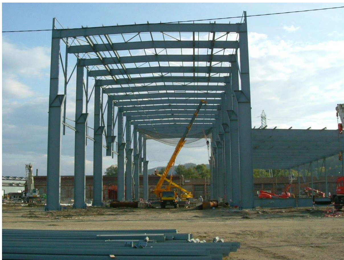
Widok głównej ramy portalowej podczas montażu
