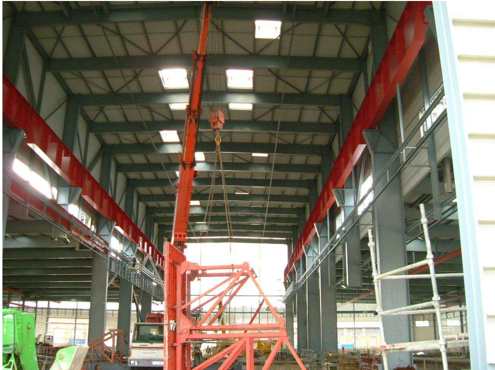
Figure 2.1 Tory podsuwnicowe i dach hali głównej
