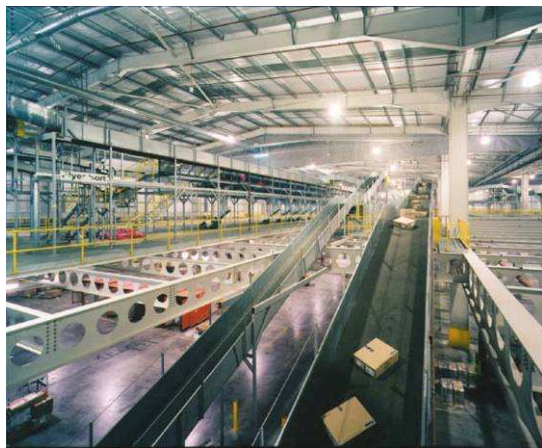
Rys. 7.1 Główne urządzenie sortujące, widoczny jest demontowany ruszt antresoli ułatwiający ewentualną rozbudowę w przyszłości
