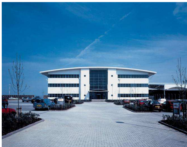
Rys. 6.2 Zakrzywiony dach biurowca
