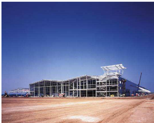
Rys. 8.1 Konstrukcja stalowa w czasie wznoszenia
