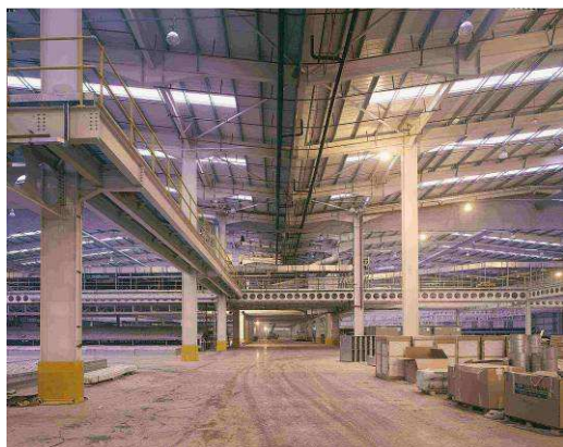
Rys. 5.2 Widok wewnętrzny – centralna droga wjazdowa Wspornikowe zadaszenie boczne
