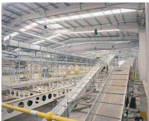
Rys. 5.1 Główne urządzenie do sortowania z widocznym systemem przenośników taśmowych, stropów antresoli, ram portalowych, cienkościennych płatwi i ocieplonego dachu
