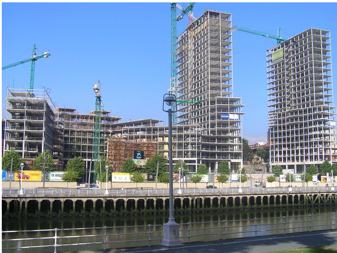
Rys. 1.1 Widok placu budowy pod koniec wznoszenia konstrukcji (lipiec 2006)
