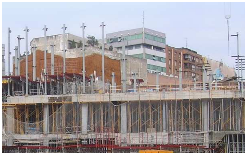
Rys. 3.2 Żelbet i stalowe słupy jako część tej samej konstrukcji.
