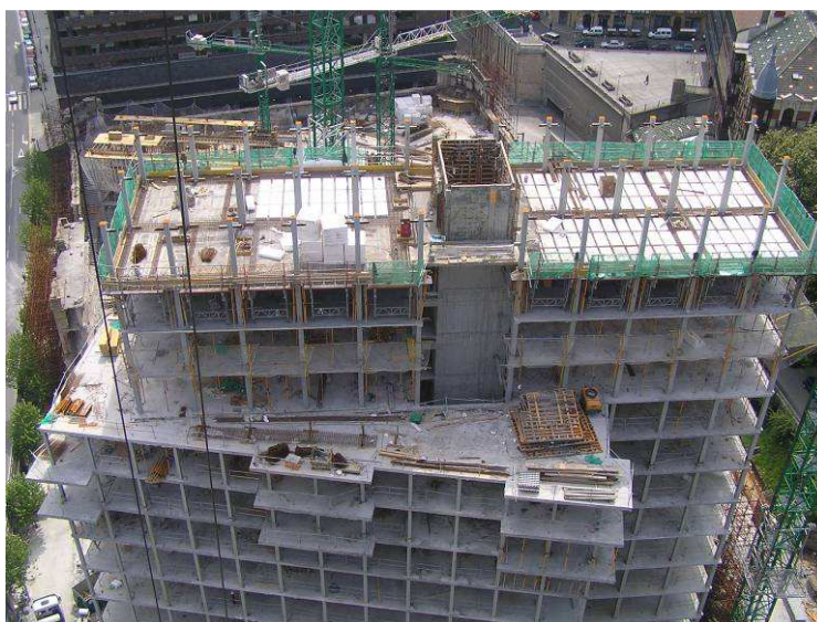
Rys. 3.1 Betonowy trzon centralny nowej konstrukcji.
