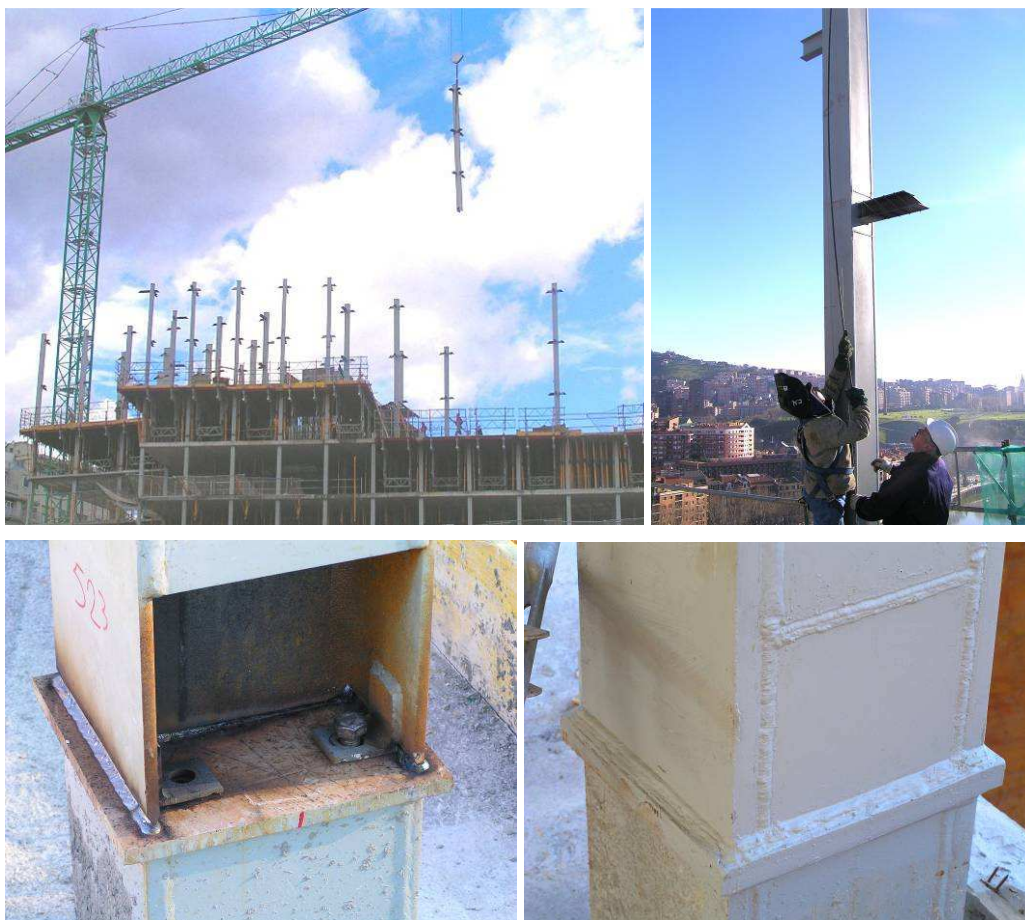
Rys. 2.1 Etapy wznoszenia słupów i wykonania ich połączeń – uzupełnienie wcześniejszych
