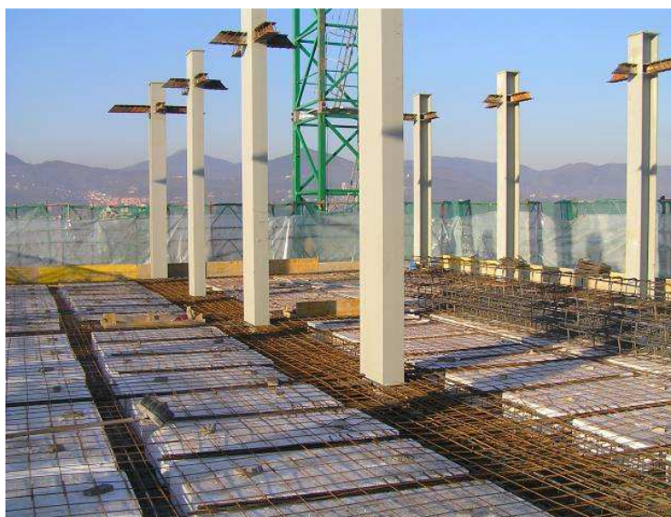
Rys. 3.3 Połączenie pomiędzy stalowymi słupami a żelbetowymi stropami.
