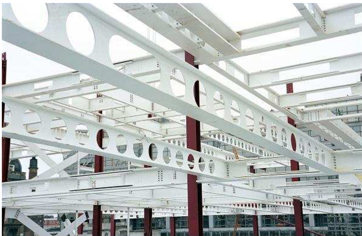
Rys. 4.2 Wtórnie przetworzone belki z otworami o różnych kształtach
