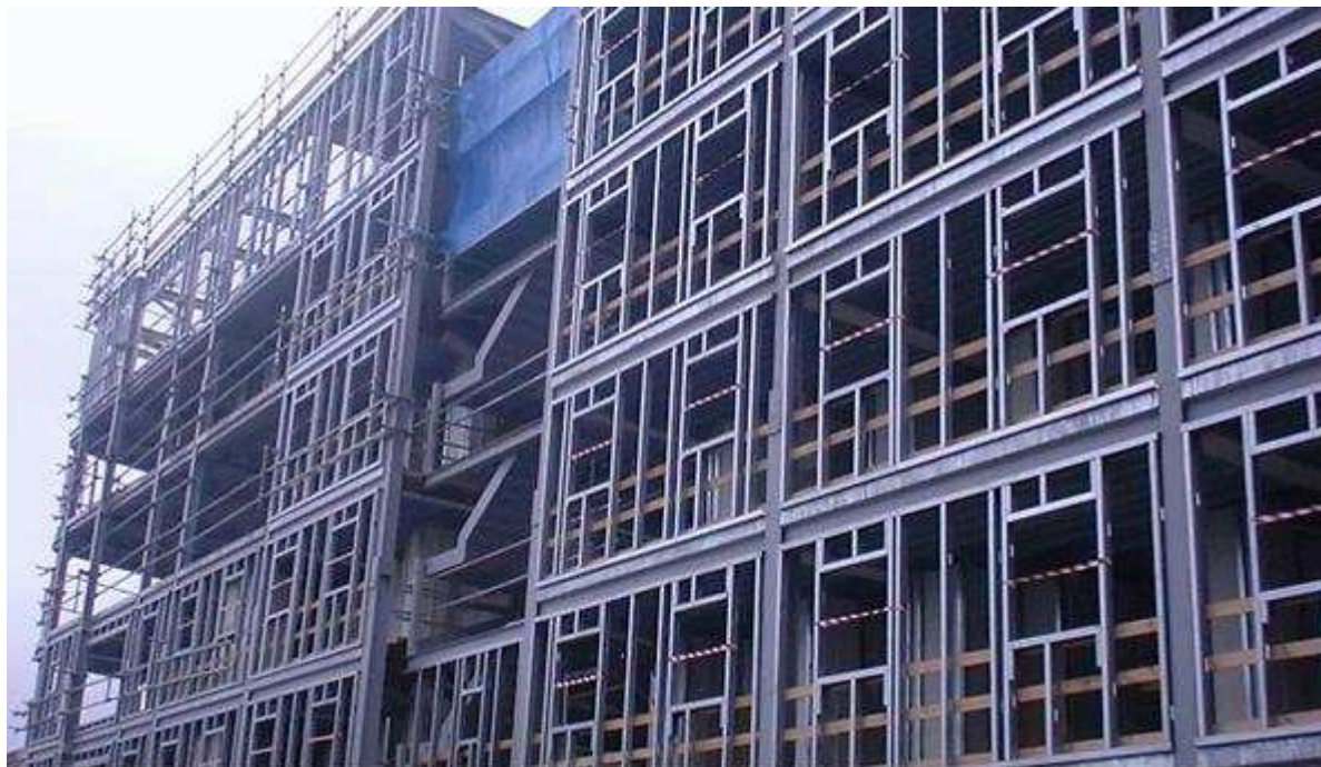
Rys. 4.7 Lekkie stalowe ściany wypełniane wykorzystywane w stalowych budynkach szkieletowych
