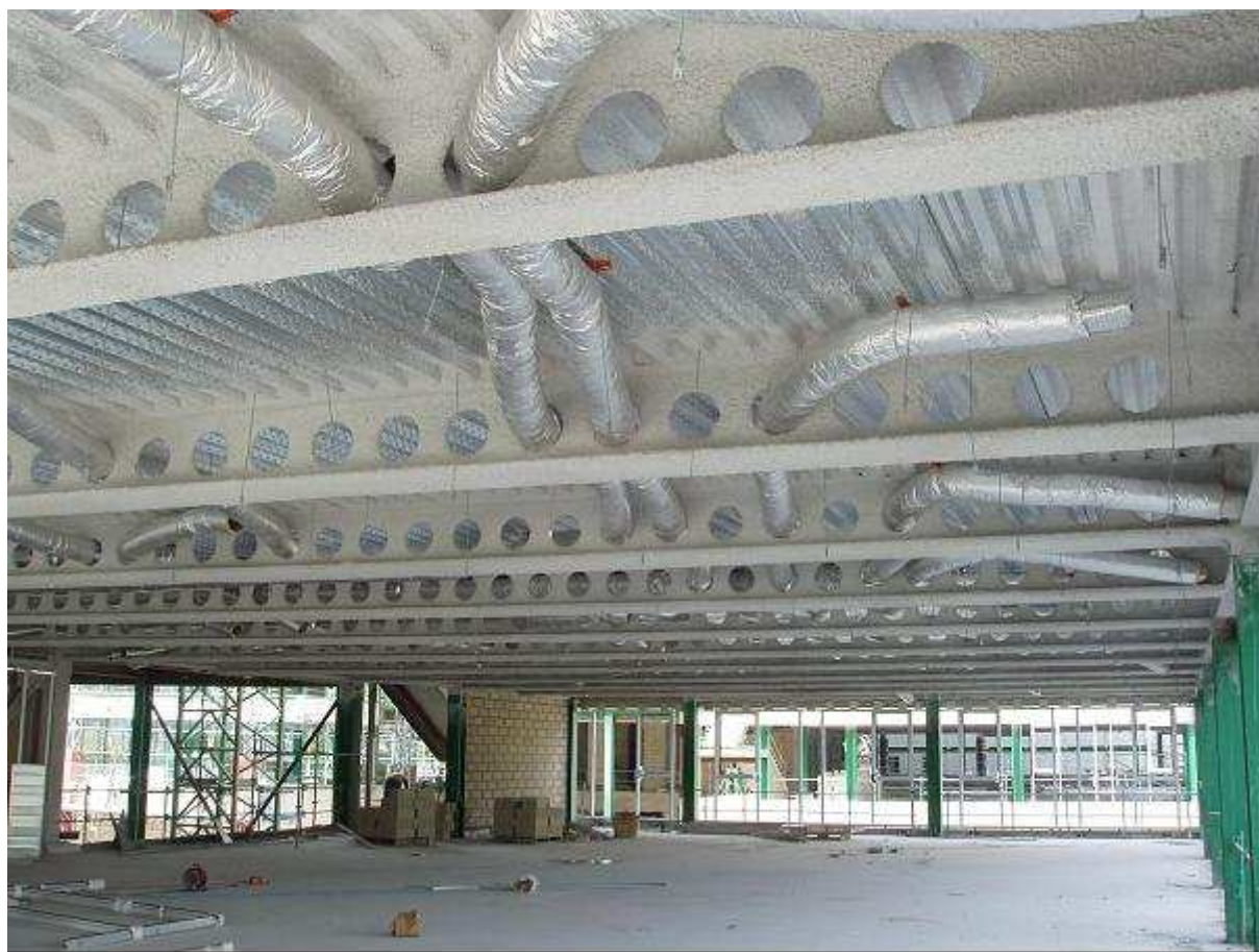
Rys. 4.1 Belki ażurowe z regularnymi otworami na instalacje
