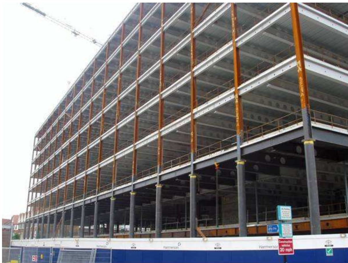
Rys. 4.4 Słupy rurowe wysunięte ze względu na odporność pożarową
