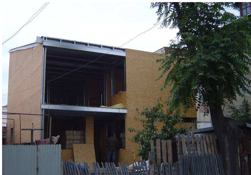
(b) szkielet stalowy z zamontowanymi wszystkimi nośnymi panelami OSB
