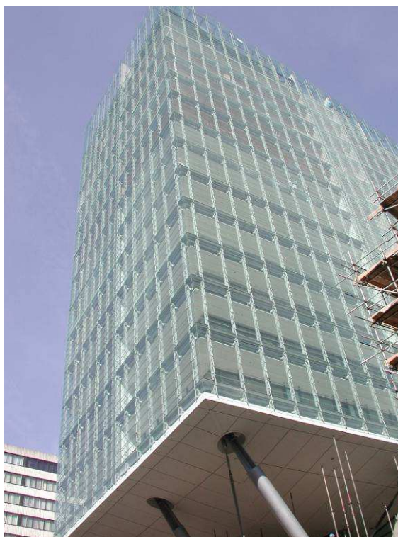
Konstrukcja nadziemna, widoczna w pełni przeszklona fasada i pochylone słupy
