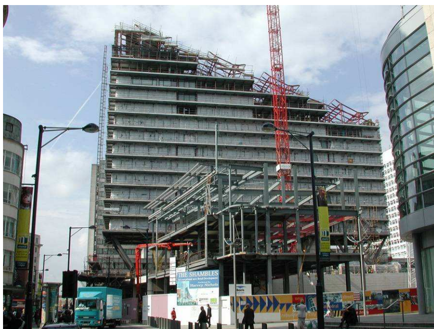
Rys. 1.1 Konstrukcja nadziemna w czasie budowy
