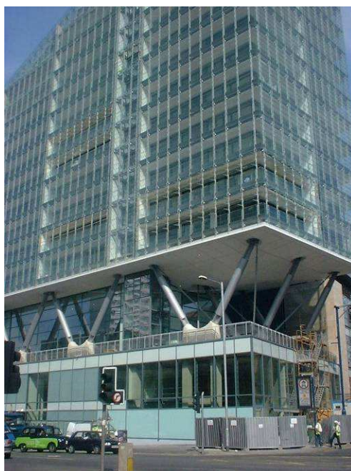
Rys. 1.2 Pochylone słupy w poziomie platformy
