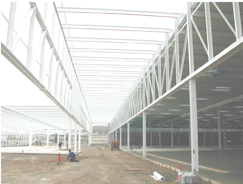
Rys. 2.2 Konstrukcja korytarza w czasie wznoszenia
