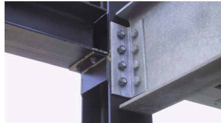
Węzeł nominalnie przegubowy
